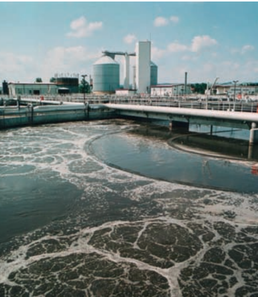
Abb. 1: Klärwerk, Foto mit freundlicher Genehmigung der Stadt Erfurt.
