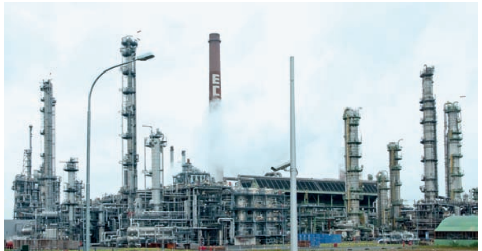
Abb. 5: Erdölchemie (EC), Fraktionierkolonnen erzeugen Destillationsprodukte, Ausschnitt der Werksanlage Bayer Dormagen. (Foto: Flo Bergmann)
